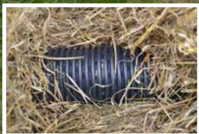
Perforeret drænrør/-ledning pakket med halm for at undgå indtrængning af sand.
