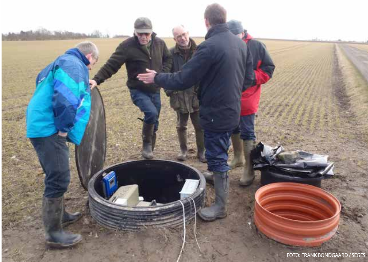
Reguleringsbrønd til styret dræning
